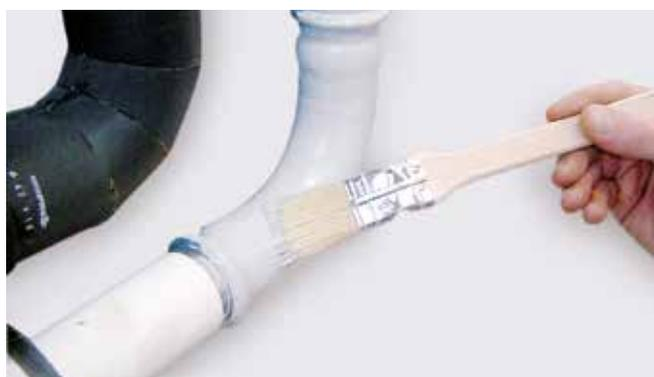
Figura 34 - Verniciatura raccordi e tubazioni con primer
