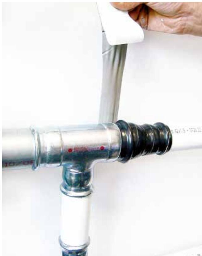
**Figura 35** – Protezione dei raccordi con nastro isobutilico
