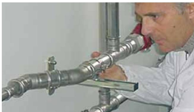
Figura 33 - Controllo della pressatura
