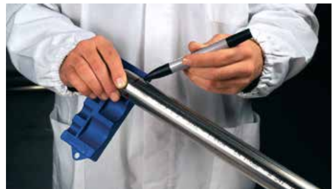
Figura 8 - Marcatura della profondità d'innesto
