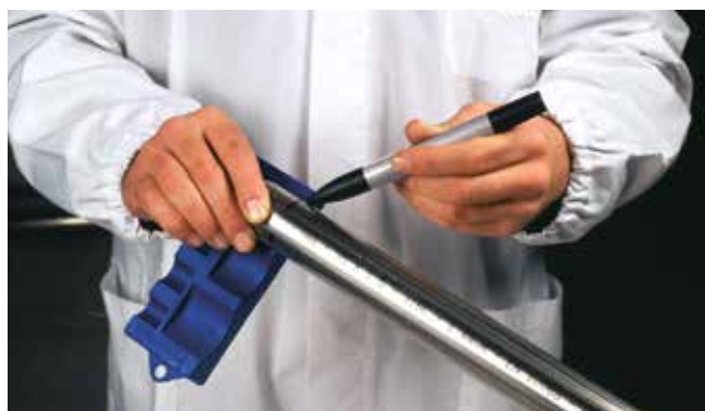
Marcatura della profondità d'innesto
