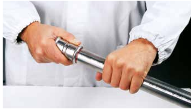
Inserimento del tubo nel raccordo a pressare
