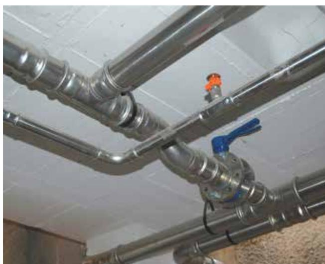
Figura 20 - **inoxPRES** - Impianto spinkler in magazzino
