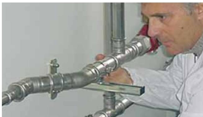
Figura 28 - Controllo della pressatura
