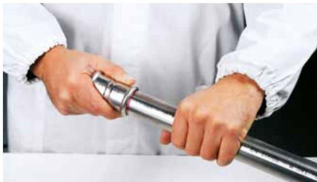
Figura 26 - Inserimento del tubo nel raccordo a pressare
