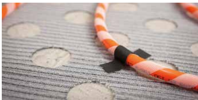
Fig. 3-2 Esempio di applicazione del nastro di fissaggio RAUTHERM SPEED
