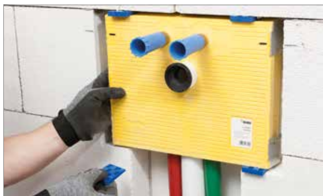
Figura 2-51 Variante 2 - fissaggio con cunei
