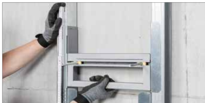
Figura 2-37 Regolazione dell'altezza del supporto portante RSB
