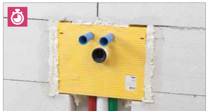
Figura 2-56 Piena capacità di carico dopo 24 ore
