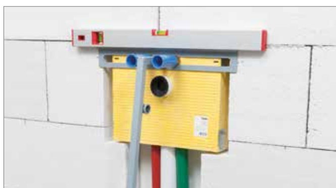
Figura 2-50 Variante 1 - fissaggio con dima
