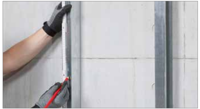
Figura 2-32 Segnare l'altezza di installazione
