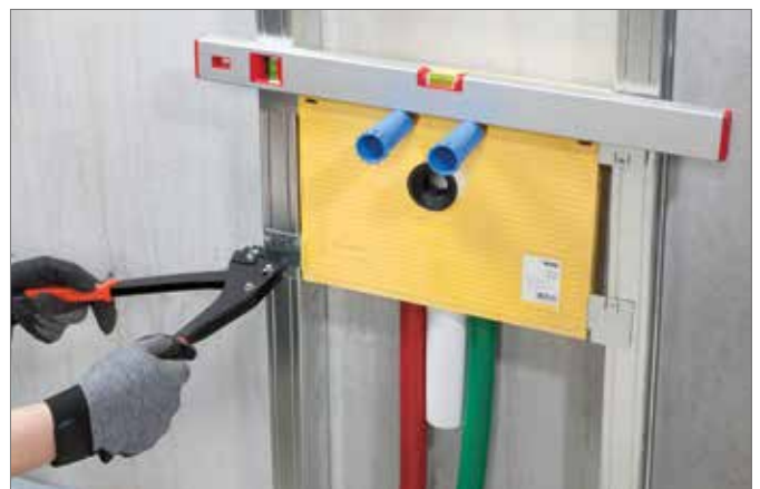
Figura 2-35 Allineamento e crimpatura delle alette di fissaggio
