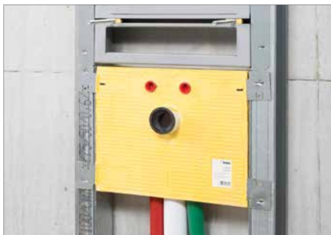
Figura 2-40 Crimpatura di un modulo sanitario di larghezza 350 mm
