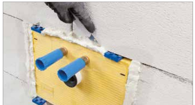
Figura 2-55 Rimozione della schiuma in eccesso
