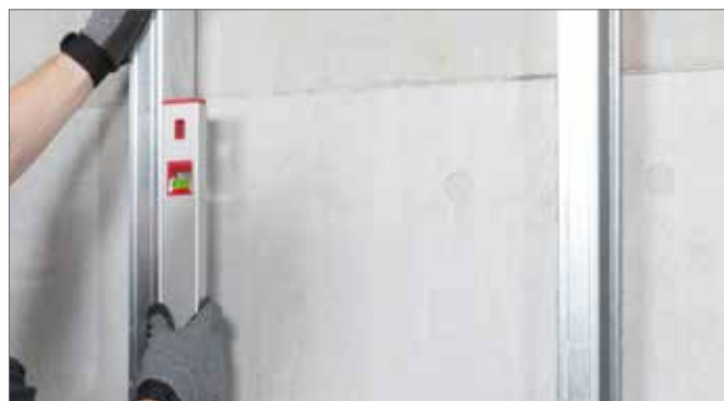
Figura 2-29 Allineare i profili per il montaggio a secco
