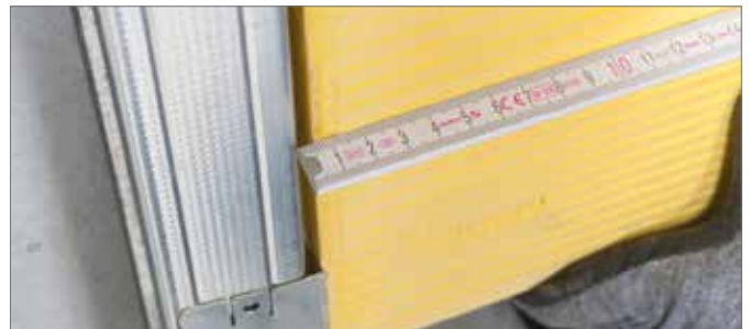
Figura 2-33 Inserimento del modulo sanitario
