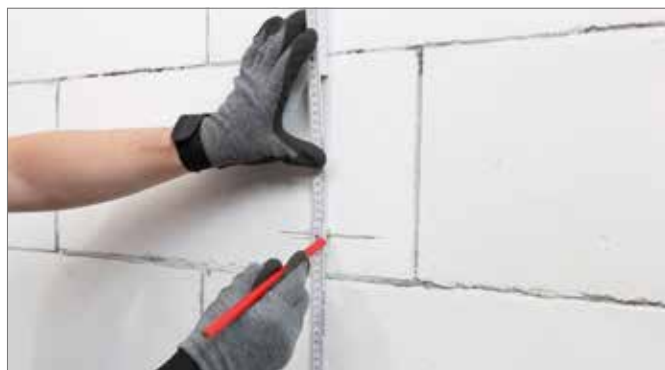
Figura 2-41 Tracciare la posizione del modulo
