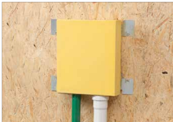
Figura 2-58 Fissaggio con pannelli in truciolato
