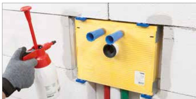
Figura 2-52 Come inumidire moduli sanitari e sottofondo
