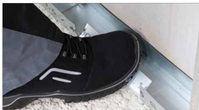
Figura 2-31 Piegare il profilo UW dove inciso
