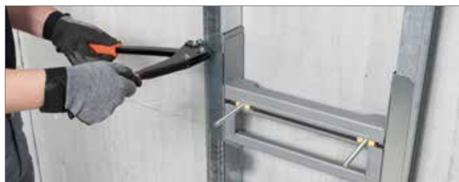
Figura 2-38 Crimpatura del supporto RSB
