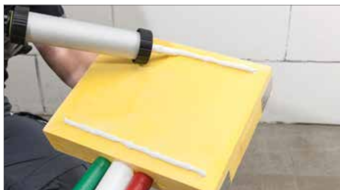
Figura 2-46 Applicazione di RSB colla di montaggio
