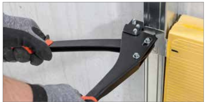
Figura 2-34 Crimpatura della prima aletta di fissaggio
