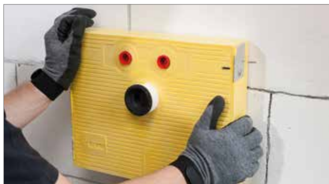
Figura 2-47 Incollaggio del modulo sanitario
