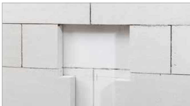
Figura 2-49 Realizzazione della cavità
