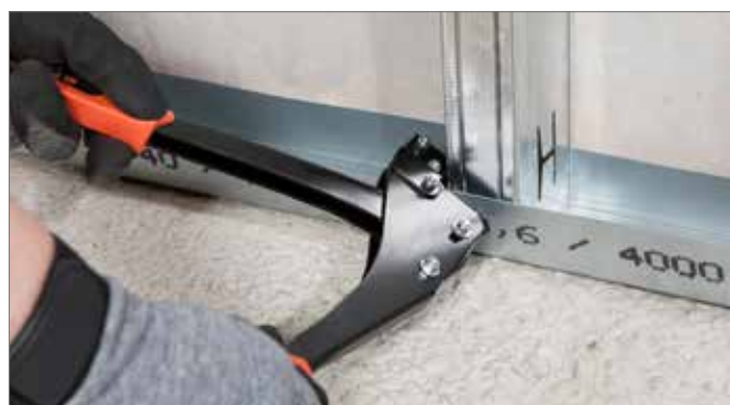
Figura 2-30 Collegare il profilo CW con quello UW
