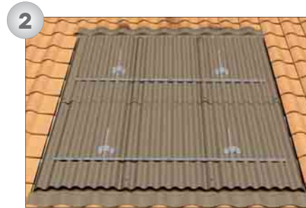
2) Ancoraggio delle convesse e della carpenteria di fissaggio dei collettori.
