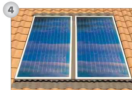
4) Finitura della posa e riposizionamento della copertura in eccesso rimossa.
