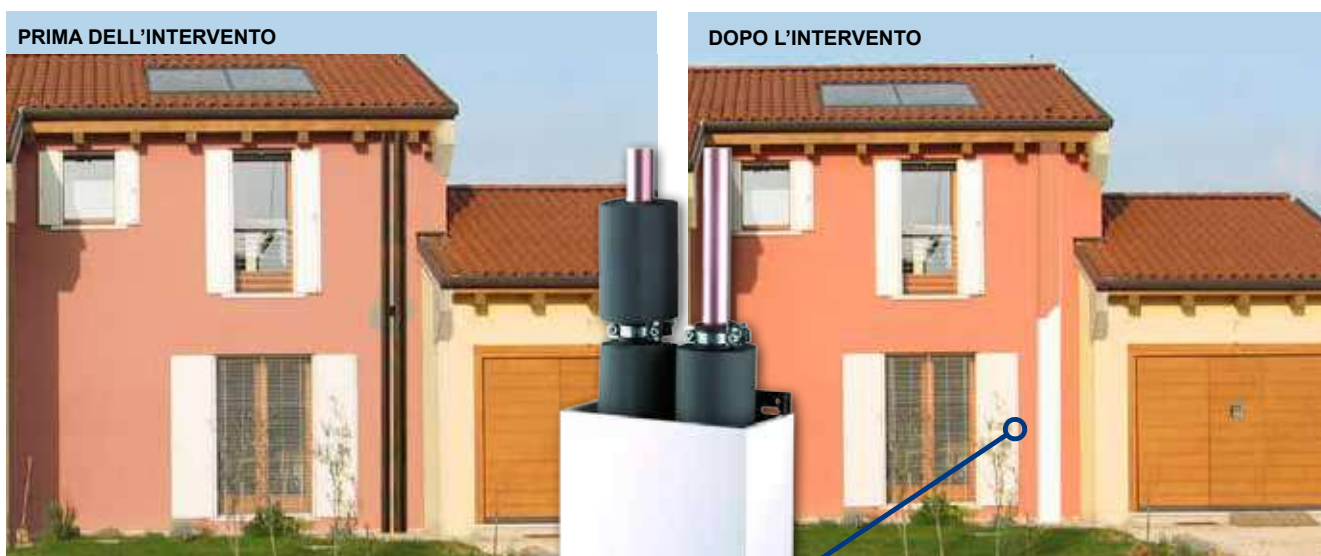
REALIZZAZIONE COLONNE DI SCARICO E SFIATO NUOVO BAGNO
