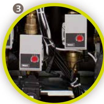
Pompa di circolazione ad alta efficienza a modulazione totale per la zona alta temperatura
